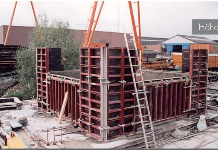
Höhenausgleich mittels Traversen
