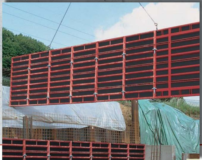
Kranversatz eines Elementverbundes mit 28 m<sup>2</sup> - sicher und stabil verbunden nur allein mit FEBE-Schnellspannklammern.
