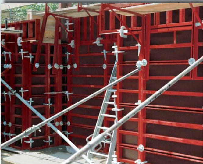
Auch mit der Großflächenschalung kann durch Einsatz verschiedener Elementbreiten jeder Grundriss geschalt werden.
