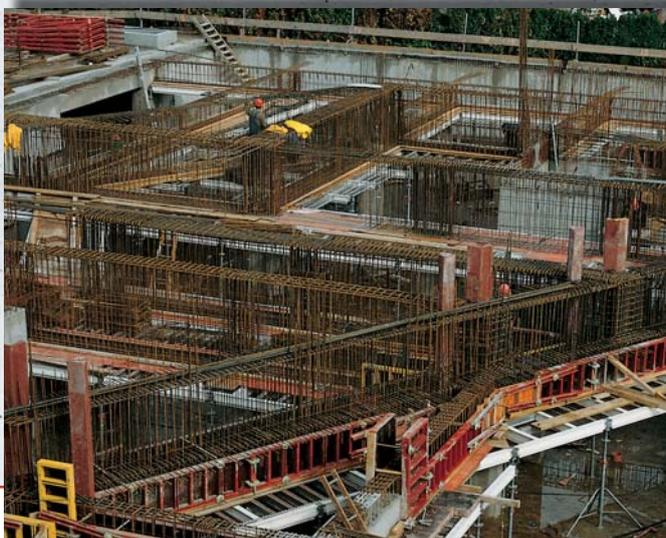
Die FEBE-Schalung ist flexibel genug, um Deckenunterzüge ohne Sonderteile zu schalen.
