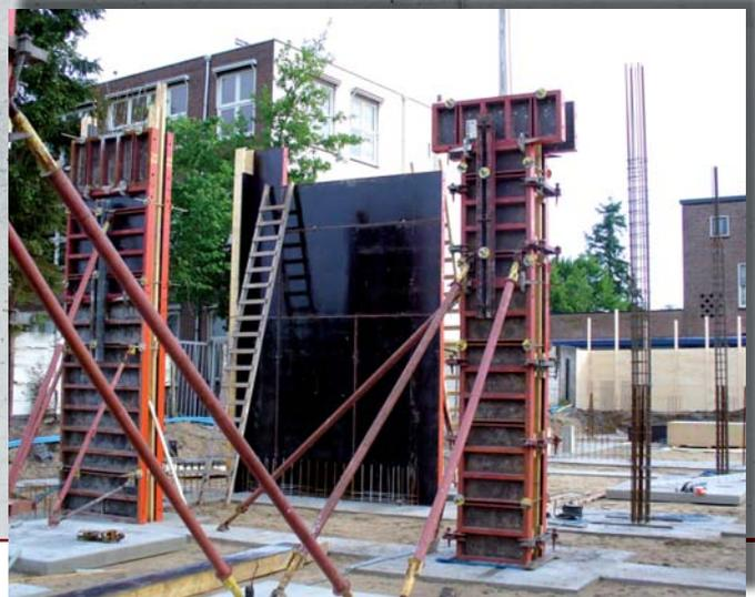
Auch aufwendige Grundrisse sind mit Standard-elementen einfach zu schalen. Einhäuptige Wände werden mit der FEBE-Abstütz-konsole geschalt.
