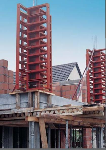
Die neue Säulenschalung kann ohne aufwendige Unterkonstruktion direkt am Eck eingesetzt werden.
